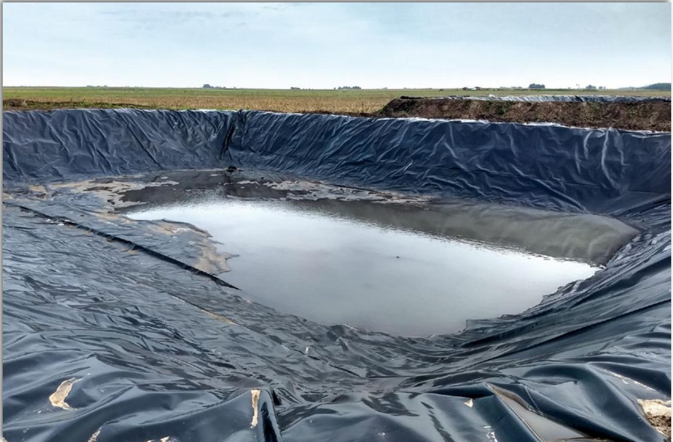
La segunda fase del proyecto consistió en el diseño de un sistema receptor de efluentes, integrado por una cámara de recolección. Gracias a la acción de una bomba, los desechos se derivan hacia una pileta de recolección (anaeróbica), para luego ser trasladados hacia una segunda pileta (facultativa).
