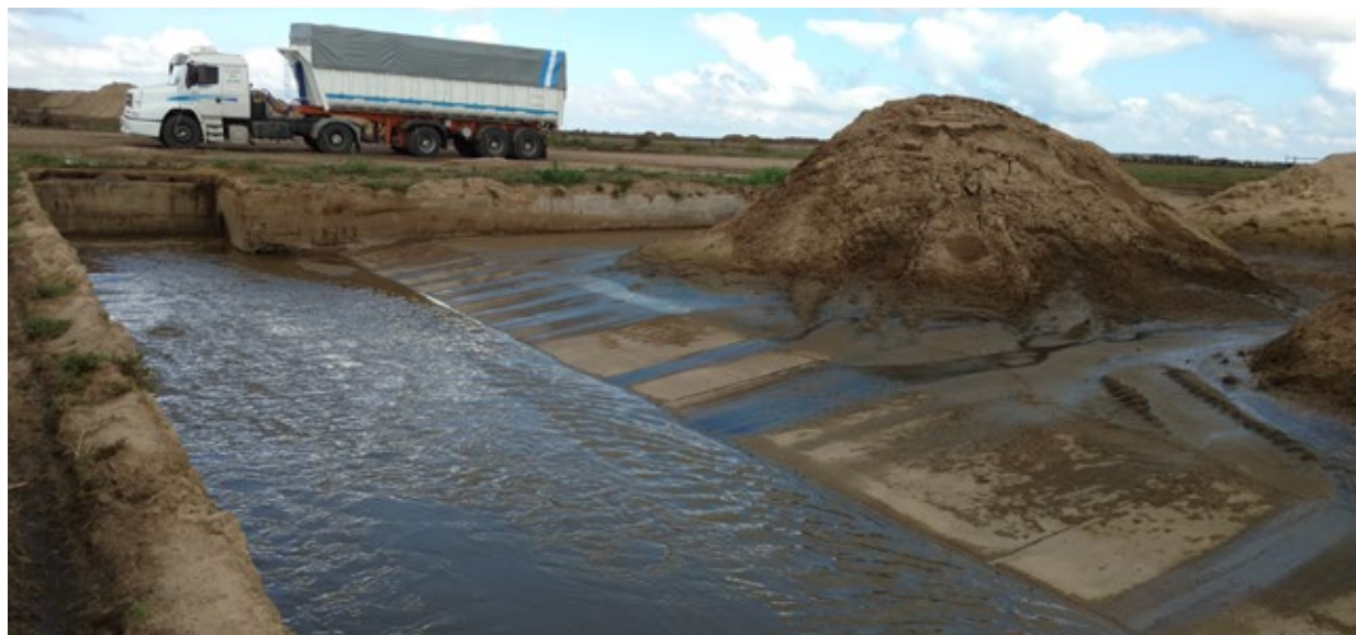
Figura 4.6 Playón de sólidos con piso de cemento y recolección del lixiviado producido por los pilones de almacenaje de estiércol (Imagen Ing. Agr. Inés Vankeirsbilck).
