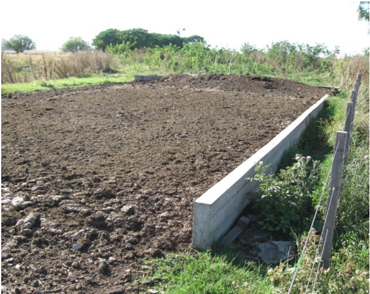
Almacenamiento de sólidos en pistas de concreto
