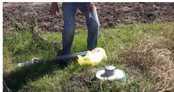
b. Construcción bien hecha con la boca del pozo elevada y protegida por un reborde de cemento.
