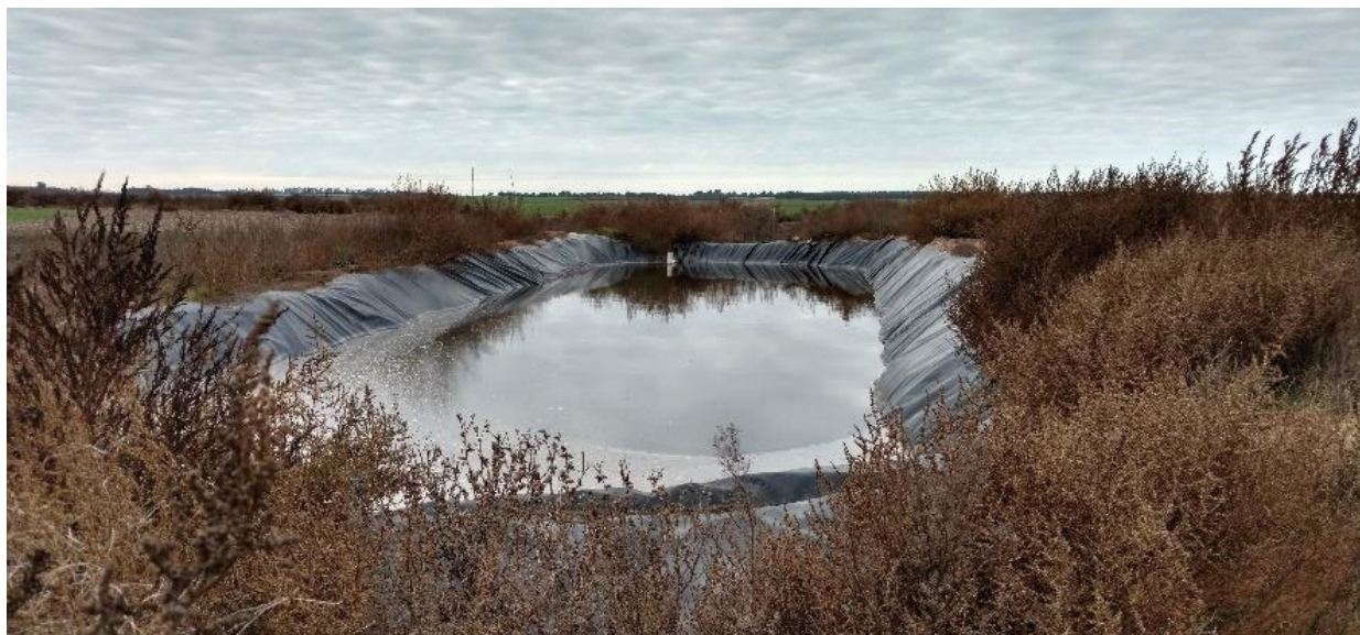
Figura 4.8 Laguna anaeróbica en un tambo comercial de la Cuenca Oeste de Buenos Aires, con falta de mantenimiento en su perímetro (Imagen Ing. Agr. Inés Vankeirsbilck).
