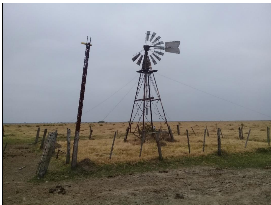
Pozo calzado en desuso por rotura del sistema de bombeo.
