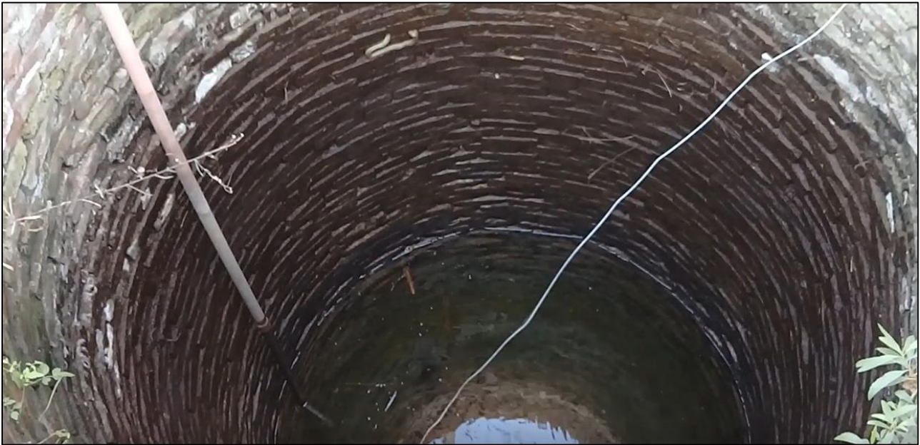
Pozo calzado en el Lote Central del Casco. Se observa como la motobomba ha deprimido el nivel del agua de manera muy riesgosa para este tipo de ambientes.
