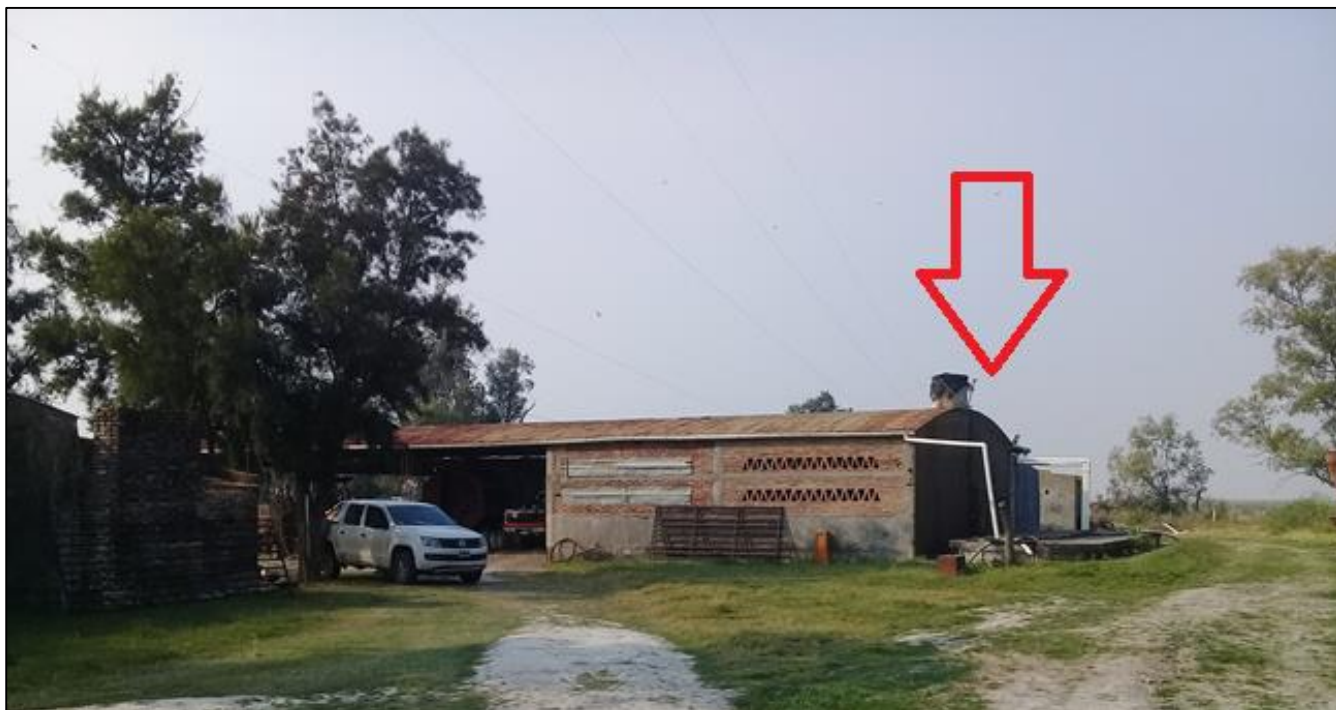
Aprovechamiento del agua de lluvia en el galpón principal del Establecimiento: canaletas y depósitos.
