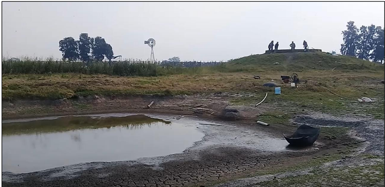
Represa, sistema patas de araña con bomba de diafragma, tanque pequeño elevado y pozo calzado con molino.
