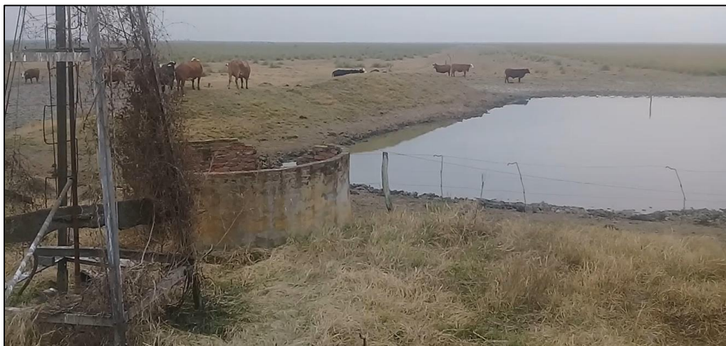
Pozo calzado con molino roto y represa al fondo.
