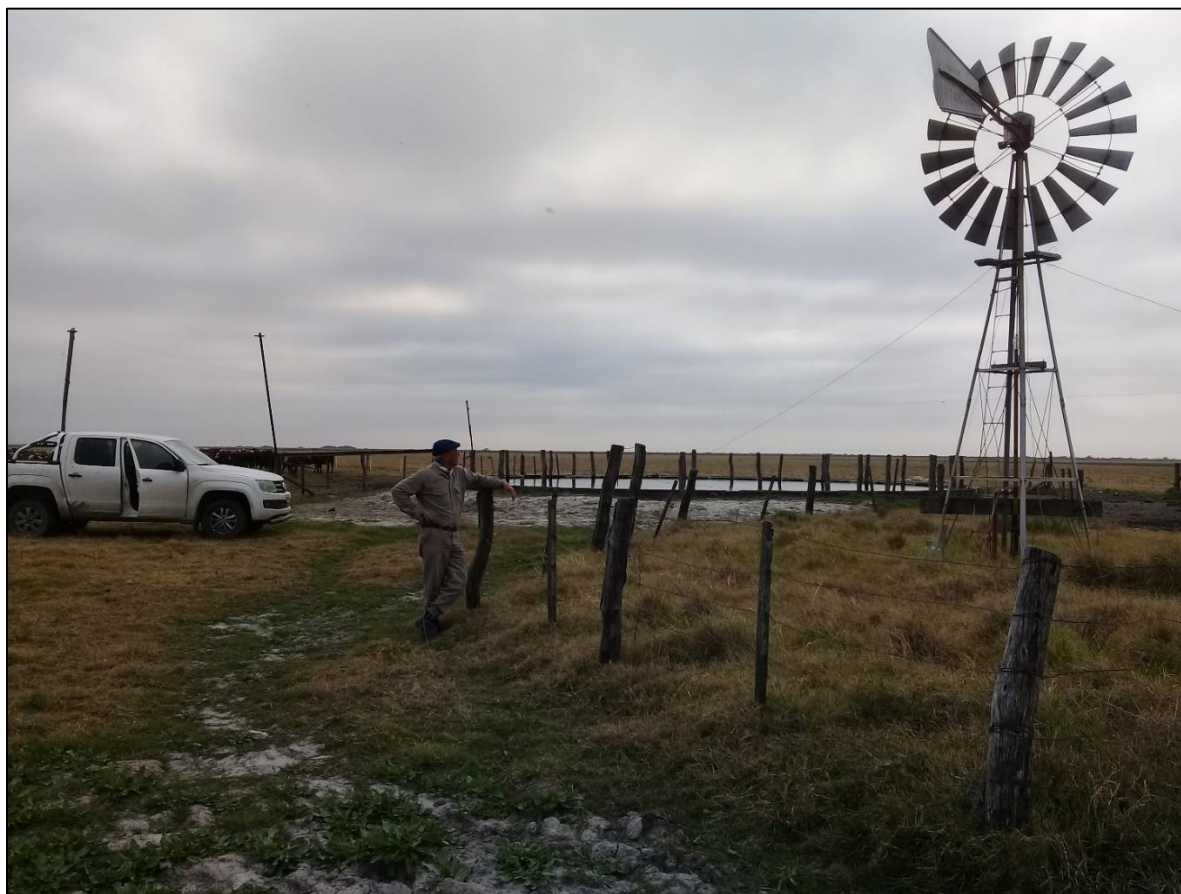
Sistema de patas de araña con 4 perforaciones que alimentan a un molino de alta eficiencia.
