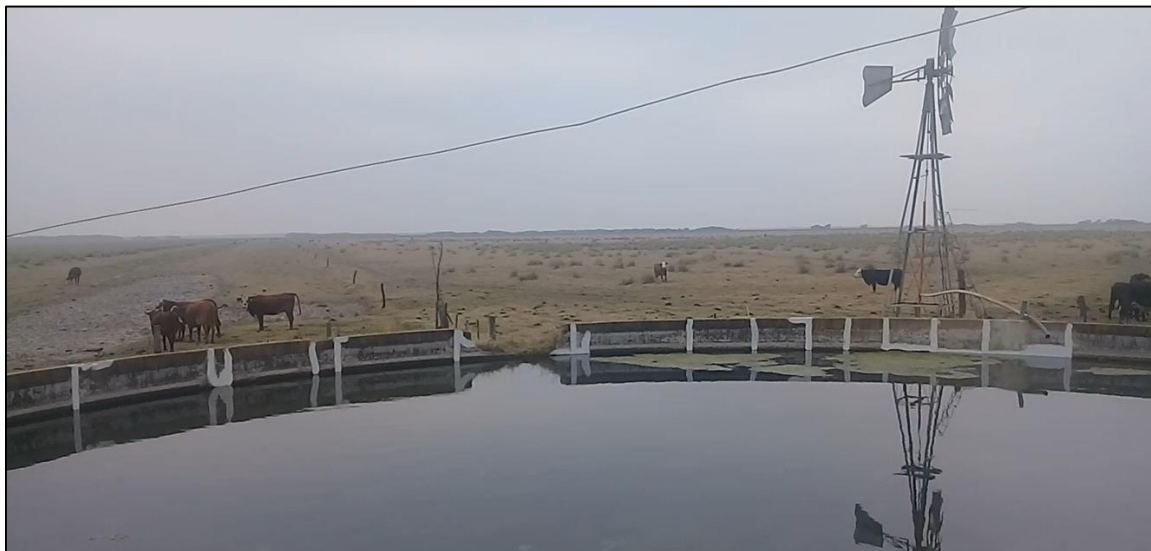
Aguada del Lote del Campo Grande: sistema patas de araña con molino y un tanque australiano.
