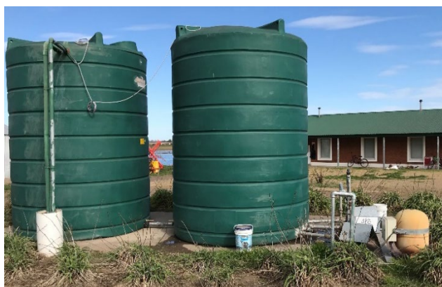
Foto 33 y 34. Dos bombas entregan agua a la placa pre-enfriadora de leche, y desde ahí a tanques verdes cerrados.
